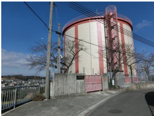
大野中区配水池 池（大野）
