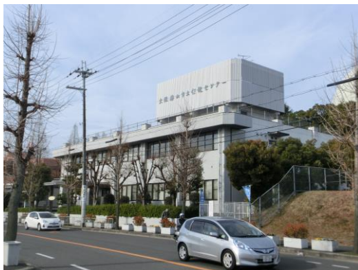
大阪狭山市立保健センター (岩室)
